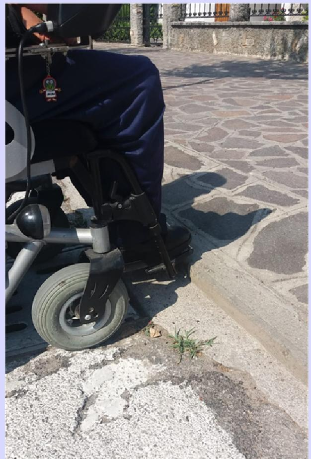
Nella foto, attraversamento pedonale davanti alla scuola primaria di Isola della Scala che mantiene il gradino del marciapiede. Nel punto più alto misurazione 15 cm ed è uno dei punti più pericolosi rilevati in via Rimembranza
