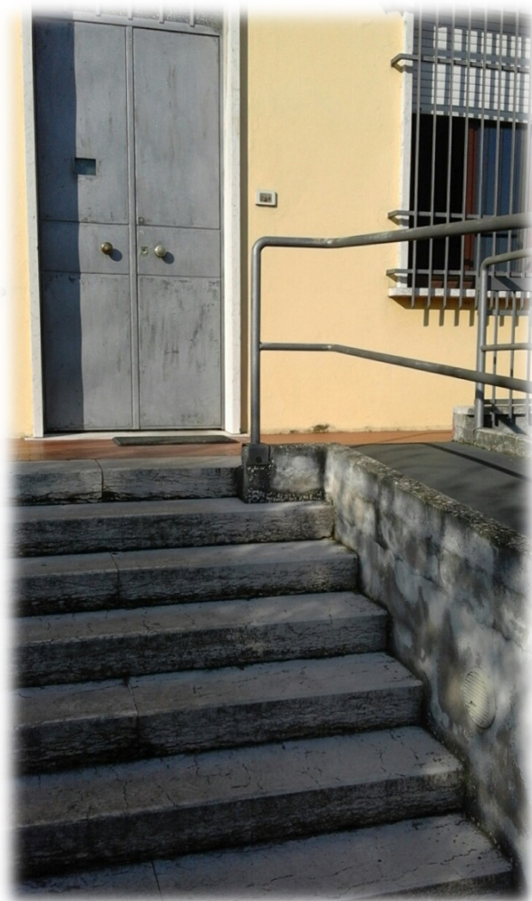
Figura 1_Stato attuale _Portoncino di ingresso metallico blindato. Portone a due ante dimensioni 52+52 cm, che verranno aperte entrambe da un operatore della caserma in caso di accesso. Mancano strisce di segnalazione antiscivolo.
