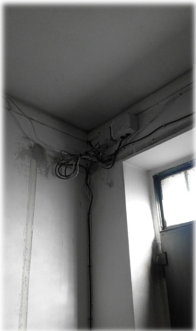
Figura 1-2_Stato attuale_ . Valutazione dei rischi: Impiantistica elettrica non a norma. Urgente sistemazione.
