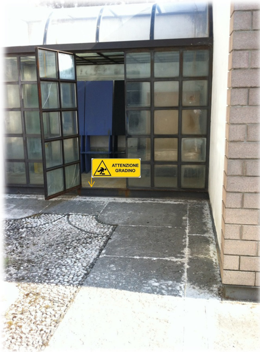
Figura 1 Stato attuale. Manca rampa per accesso in quota. Porta troppo stretta per accesso carrozzina 78 cm con svolta a destra.
