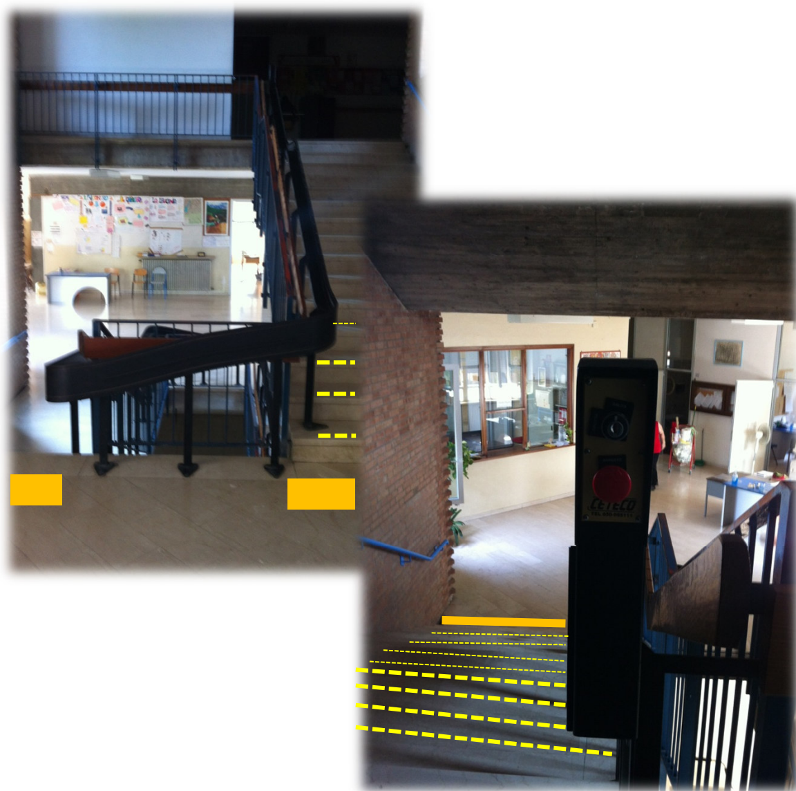
Figura 1_Stato in progetto. Inserimento delle fasce antiscivolo e fasce 30 cm inizio e fine rampa
