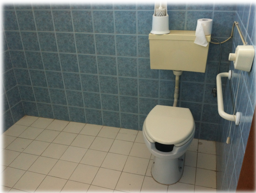
Figura 1_Stato attuale_ Bagno per disabili al piano rialzato. Servizio igienico a norma. Porte di accesso sul percorso >80 cm
