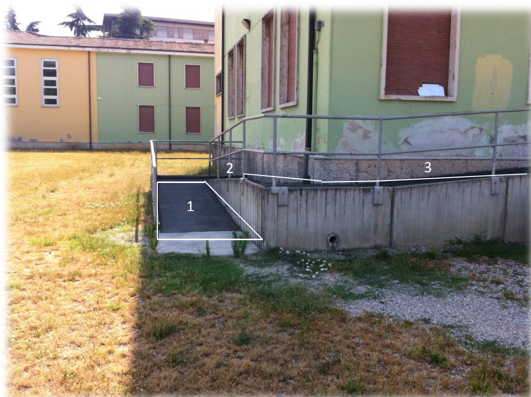
Figura 1_ Stato in progetto _Si propone, partendo dall'alto, impostare a scendere la pendenza all'8% massimo creando un innalzamento della pavimentazione. Le rampe si raccorderanno in prossimità dei pianerottoli di arrivo mentre la rampa 1 anticiperà il suo inizio. Rifacimento del rivestimento della rampa stessa. Per ovviare all'altezza della cordonata di bordo, si inseriranno delle lame stondate in sommità per ovviare al calo di altezza , ripristinando così la situazione iniziale. Parapetto avrà modifica in altezza tollerabili.
