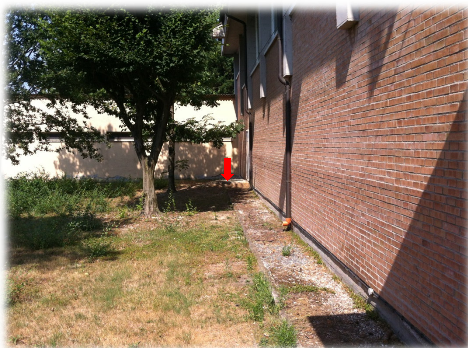
Figura 1_ Stato attuale. Uscita di sicurezza dalla palestra arriva ad una piazzola di circa 3x1,50 metri per poi avere un gradino con il terreno circostante di circa 20 cm. Si consiglia di eseguire un rinterro con stabilizzato per creare un allargamento della zona di uscita.
