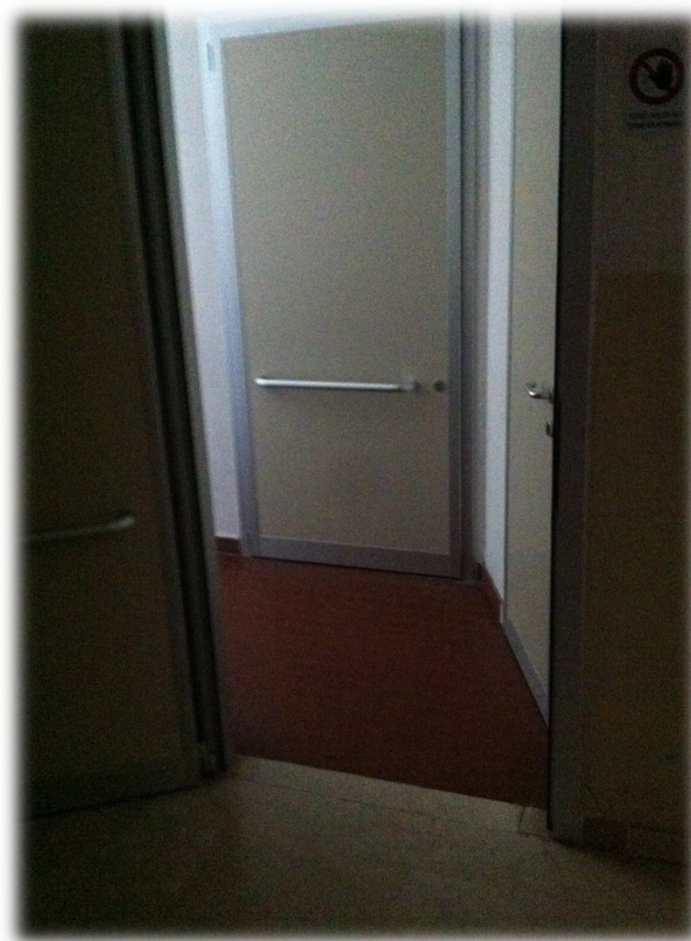
Figura 1_ Stato attuale. Bagno per disabili piano primo 180x180 cm. Passaggio tra vaso e lavabo 75 cm. Affiancamento vaso >100 cm. Limitato l'accostamento alla tazza. Lavabo e vaso antistante >80 cm. Asse vaso a 40 cm da parete. Presenti maniglioni. Rimuovere il piccolo banco presente all'interno. Manca segnaletica sulle porte per indicazione bagno disabili e suddivisione anche per sesso. Mancano segnalatori a bandiera locali servizi igienici.
