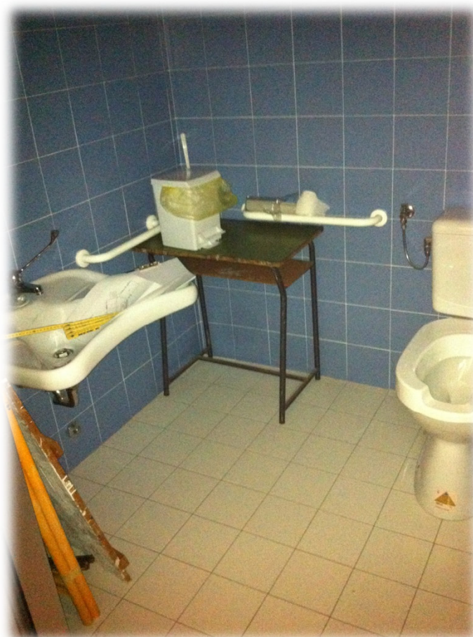
Figura 1_ Stato attuale. Bagno per disabili piano rialzato 180x180 cm. Passaggio tra vaso e lavabo 75 cm. Affiancamento vaso >100 cm. Limitato l'accostamento alla tazza. Lavabo e vaso antistante >80 cm. Asse vaso a 40 cm da parete. Presenti maniglioni. Rimuovere il piccolo banco presente all'interno. Manca segnaletica di indicazione servizi igienici.
