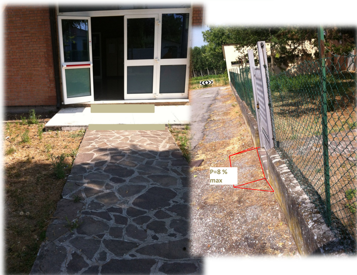
Figura 1-2_Stato in progetto. Creazione di rampe con lamierato bugnati antiscivolo per le zone nelle immediate vicinanze del fabbricato. Rampa in cemento mediante tassellatura asfalto, getto in cls con finitura scopata. Inserimento di un citofono wireless sul cancelletto ad una altezza massima di 130 cm.
