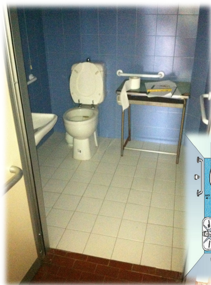
Figura 1_ Stato in progetto. Rimuovere il piccolo banco presente all'interno che intralcia l'affiancamento al vaso. Mancano segnalatori bagno per disabili sulla porta e anche a bandiera esterni.
