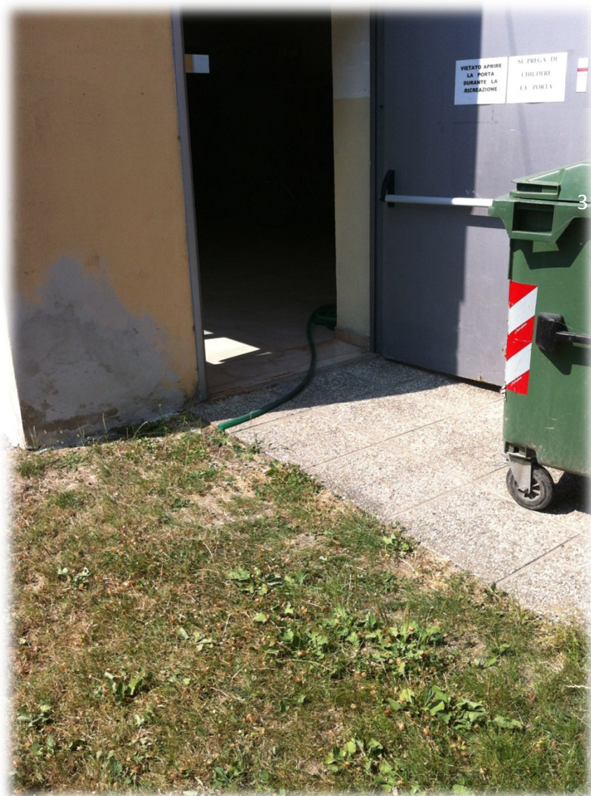
Figura 1_Stato attuale _Ingresso al plesso laterale con porta metallica, soglia 1 cm dimensione porta >90 cm I cassonetto è presente al momento della foto , come ferma porta, solo perché degli operatori stavano lavando le pavimentazioni interne e serviva giro d'aria per l'asciugatura.Nella porta non è presente un campanello e/o citofono.
