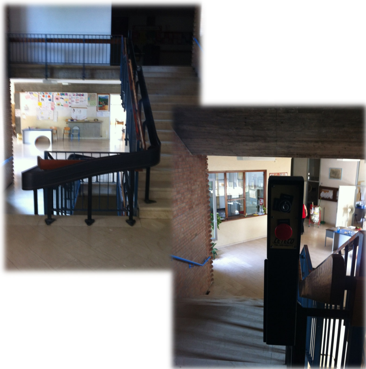
Figura 1_ Stato attuale _L'accesso ai piani è garantito da un servoscala della CETECO con pianale che collega i piani terra/rialzato/mezzanino (segreteria) e primo. Presente il corrimano sulla scala da ambo i lati. Per la parte interna non utilizzabile causa la presenza della rotaia servoscala. Esistente l'allungamento del corrimano esterno 30 cm oltre l'ultimo gradino scala. Non presenti fasce antiscivolo e fasce 30 cm inizio e fine rampa. Carente la segnaletica di indicazione servizi igienici, aule, segreteria etc.ai vari piani.
