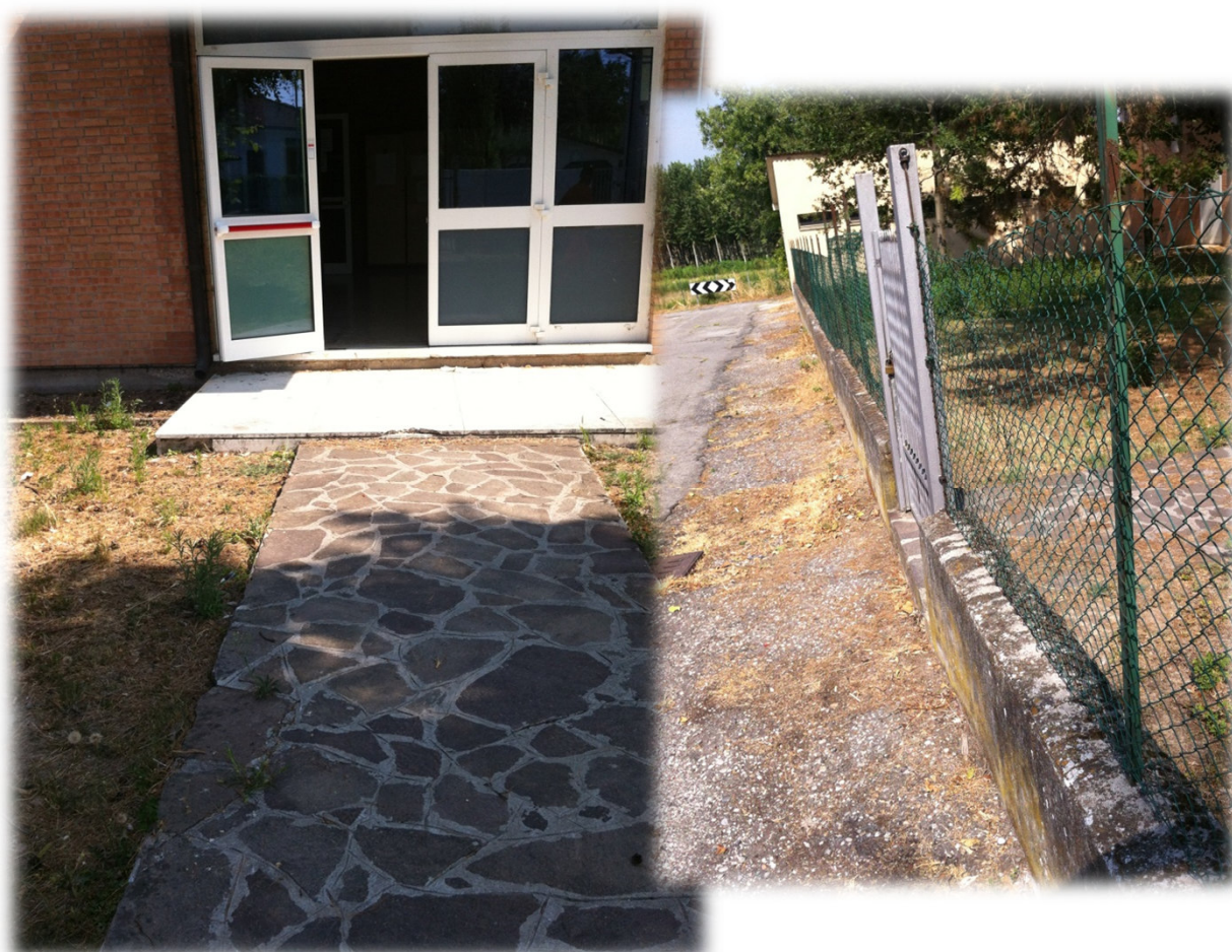
Figura 1-2_Stato attuale. Uscita di emergenza da atrio palestra. Gradino di 7 cm di soglia fabbricato e 3 cm tra pavimentazioni in marmo e porfido. Gradino di ingresso sul cancelletto pedonale di 7 cm. In caso di utilizzo da parte di esterni della palestra il percorso non è accessibile da portatori di Handicap.
