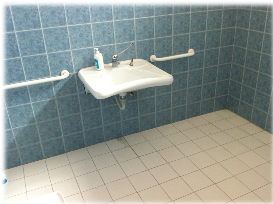
Figura 2_Stato attuale_ Bagno per disabili al piano rialzato. Servizio igienico a norma. Porte di accesso sul percorso >80 cm.
