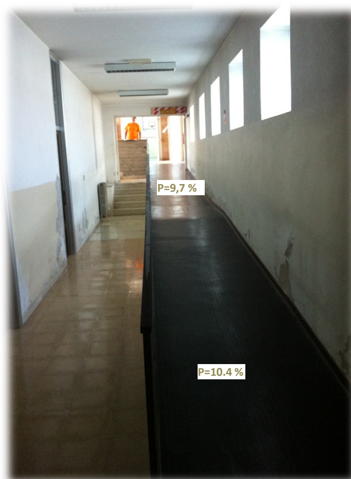
Figura 1_Stato attuale. Rampa di accesso dal piano interrato al piano (palestra) rialzato. Rampa con larghezza 120 cm. Pendenze prima tratta 10,4% e seconda tratta 9,7%. L'arrivo della rampa coincide con l'abbassamento di una trave strutturale. Altezza rilevata 1,66 cm (<200 cm eventuale porta) . Non deve essere considerata come via di fuga ma solo la scala.
