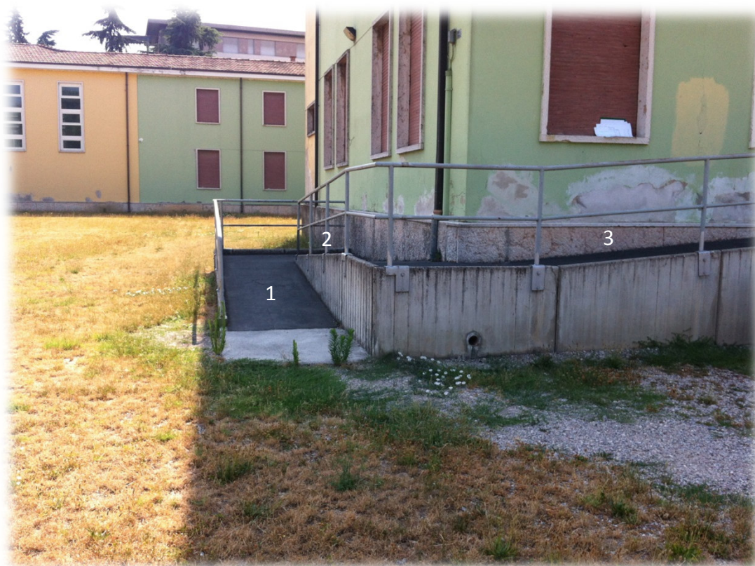
Figura 1_Stato attuale _Rampa per accesso in quota.
